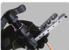
สอดท่อจนชนกับแผ่นกระสวย
