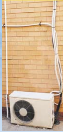
ภาพก่อนติดตั้ง SLIMDUCT
