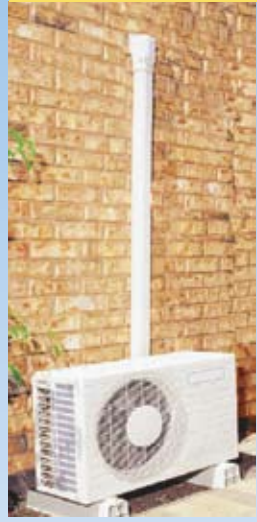
ภาพหลังติดตั้ง SLIMDUCT
